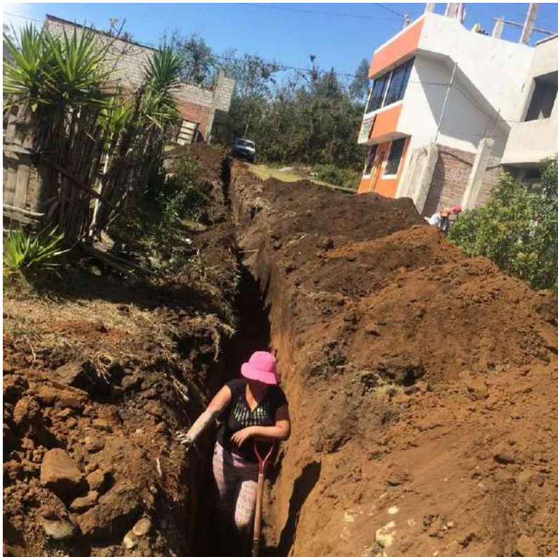
Construcción del alcantarillado sanitario del Plan Mi Yata 1, en la parroquia Urbana de San Miguel sector Tumbiguan.
